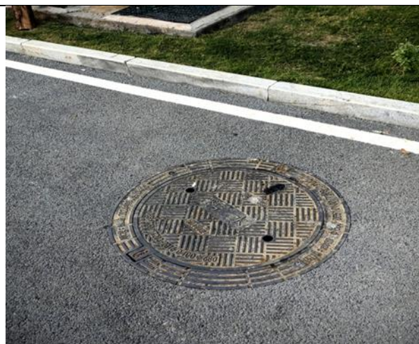
污水预处理池
