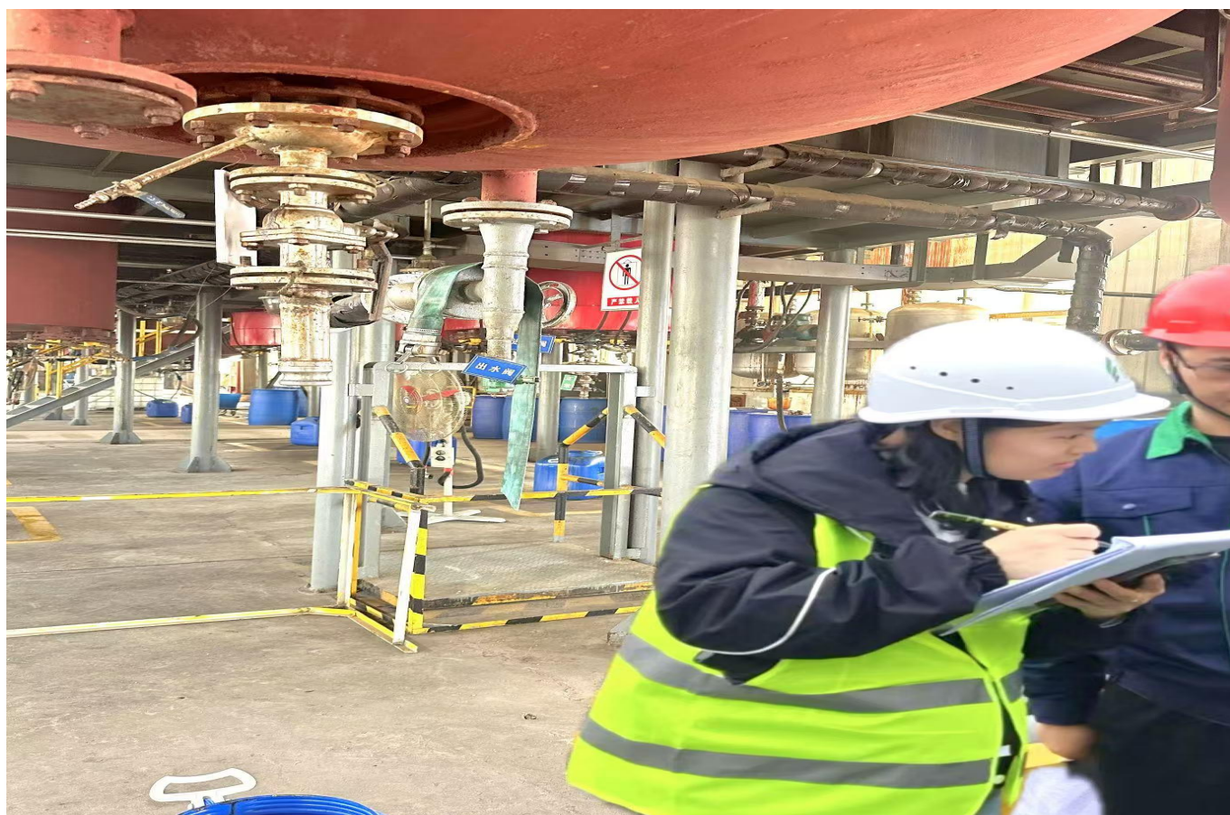
现场调查照片
