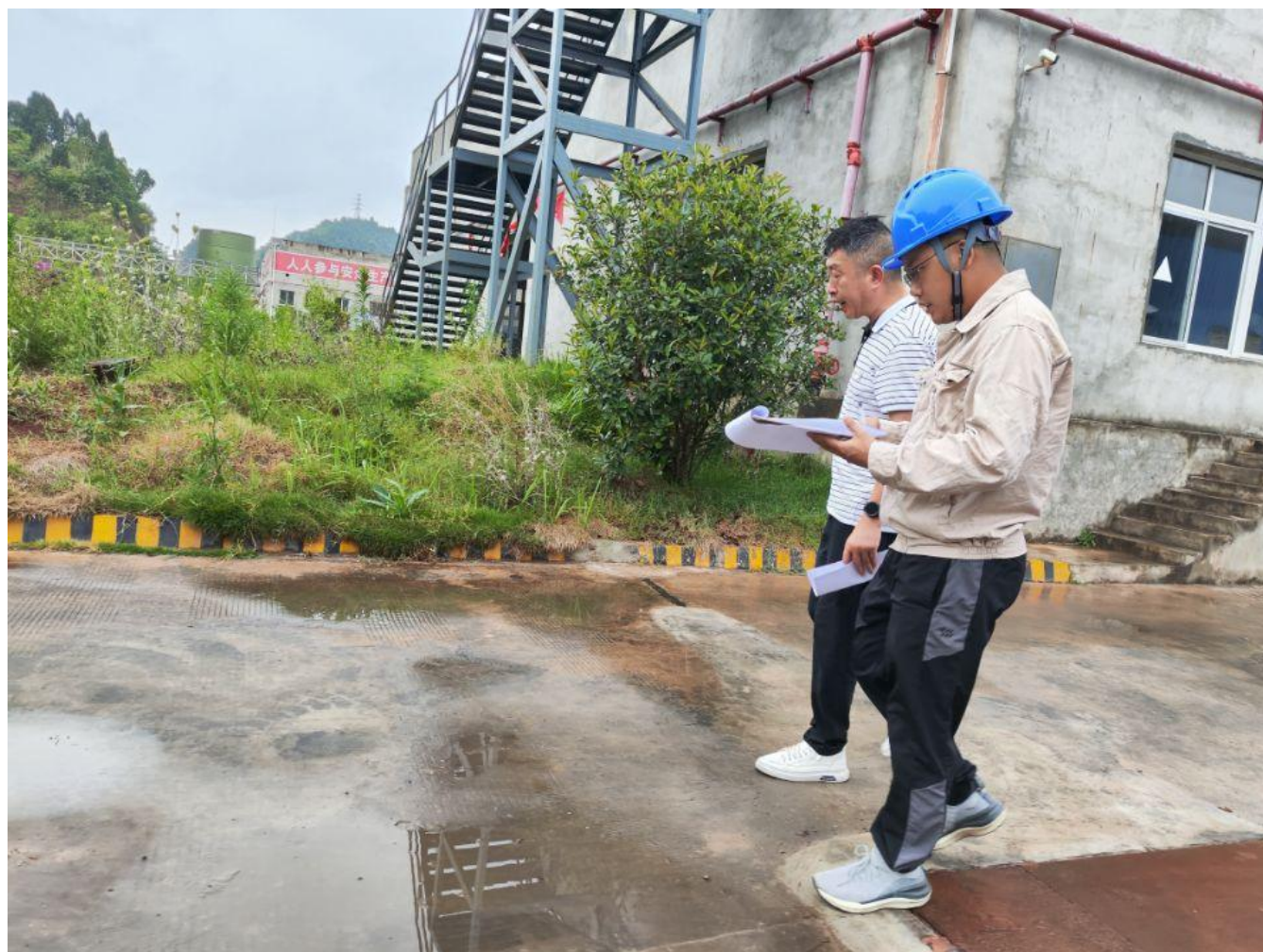
现场调查照片
