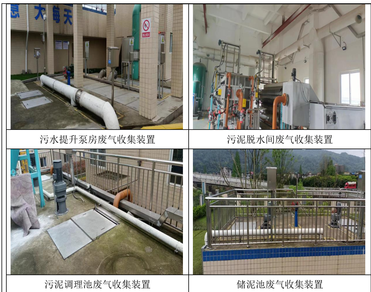
图3-3 部分环保措施现状照片
