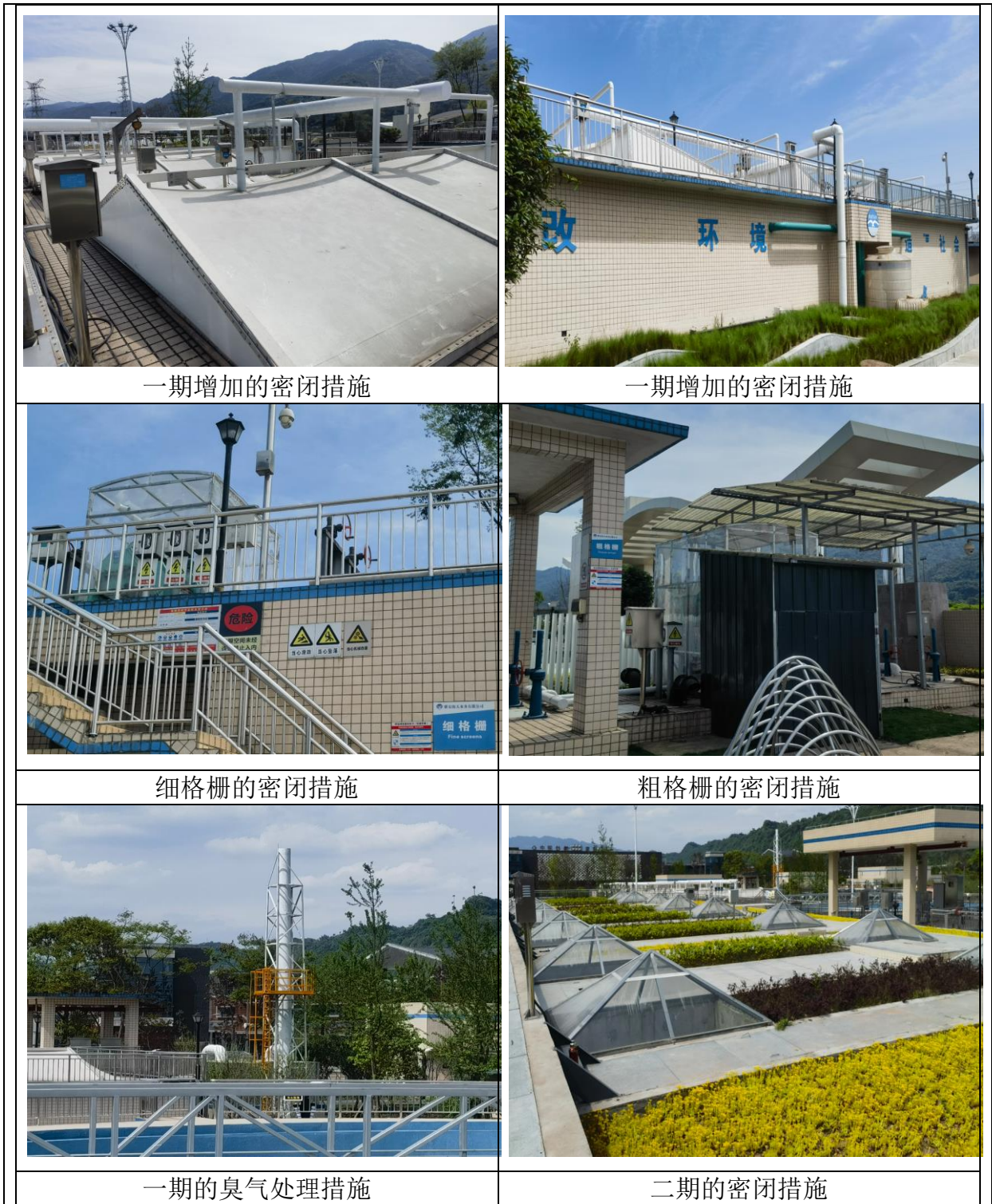
图3-1 部分环保措施现状照片
