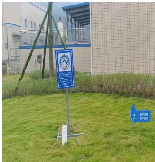
地下水监测井
