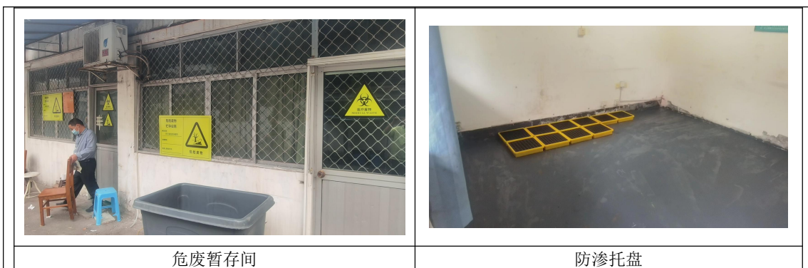
图 3-7 危废暂存间环保设施图
