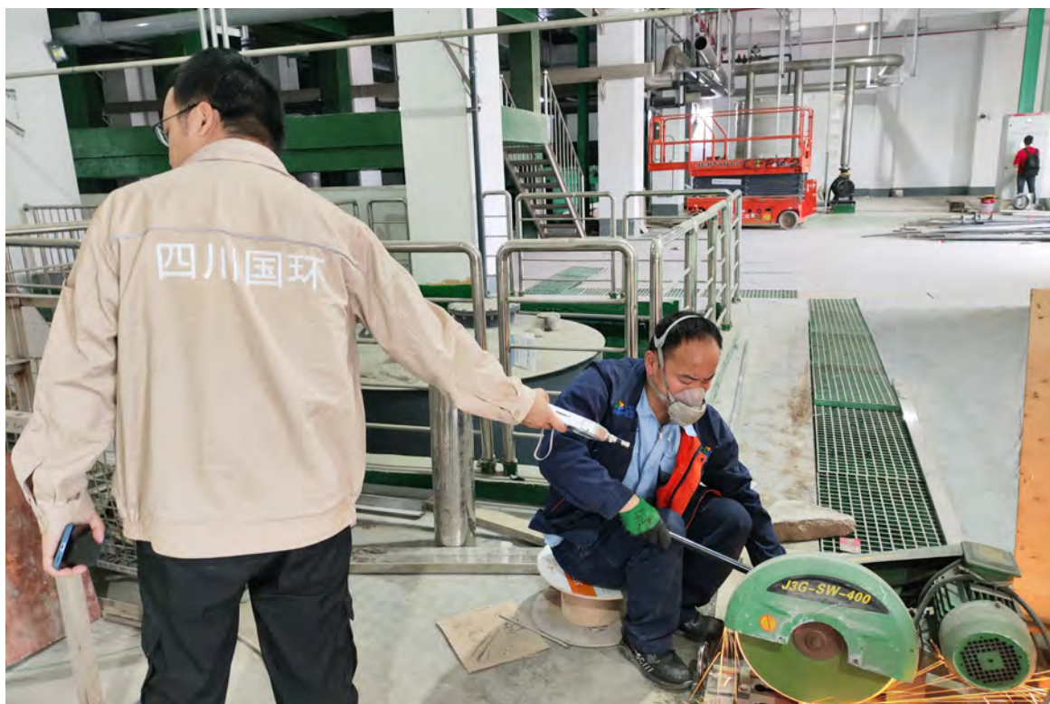
现场采样、检测照片
