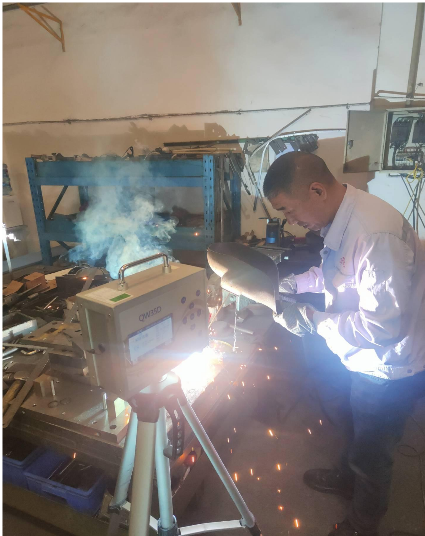
现场采样、检测照片
