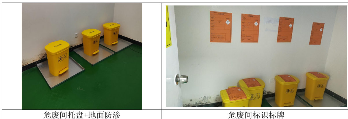
图 3-5 危废暂存间现状图
