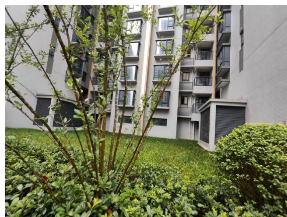
柴油发电机自带硝烟净化装置+地面排风口（发电机燃烧废气）
