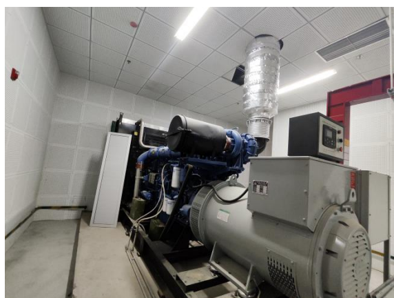
柴油发电机自带硝烟净化装置+地面排风口（发电机燃烧废气）
