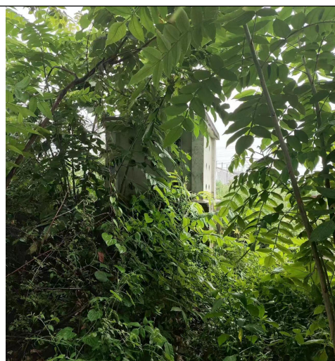
电缆隧道通风井
