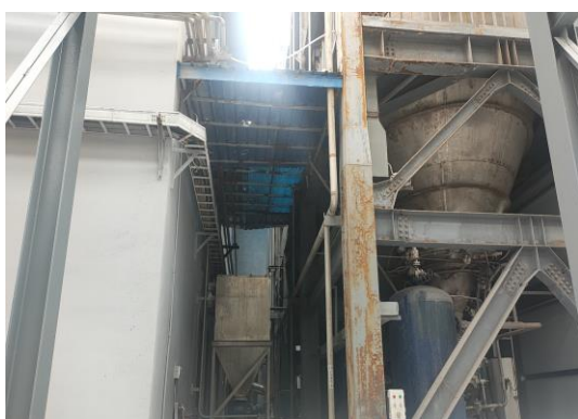
包装工段除尘器
