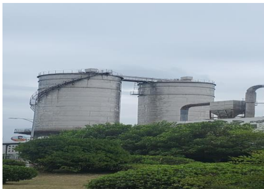
900t 料仓仓顶除尘器
