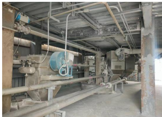
70t 料仓仓顶除尘器
