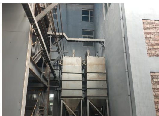
包装工段除尘器
