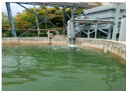
污水处理站出水口及回用水池
