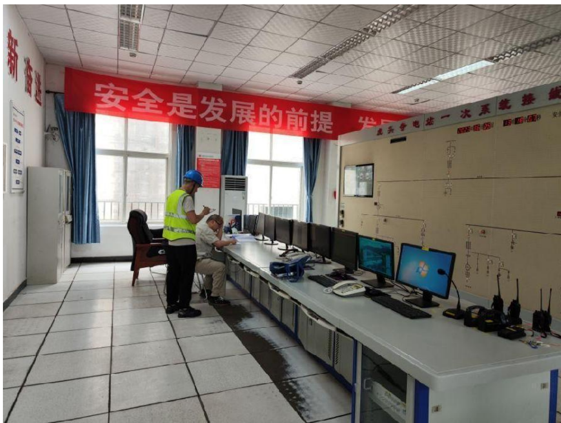
现场调查照片
