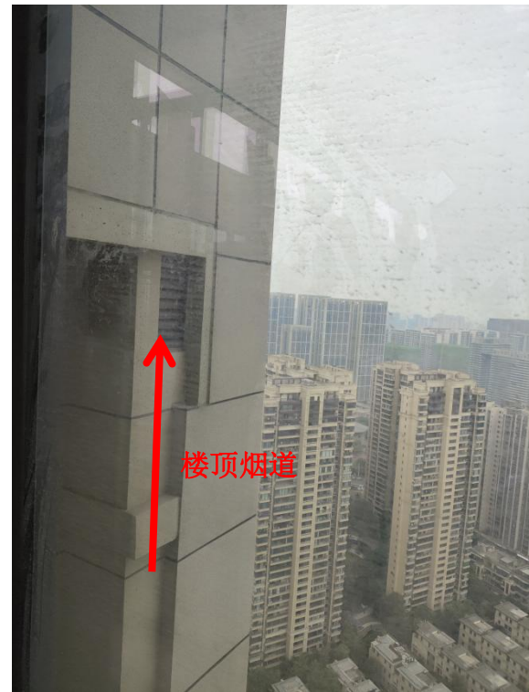
柴油发电机自带硝烟净化装置+楼顶排气筒（发电机燃烧废气）
