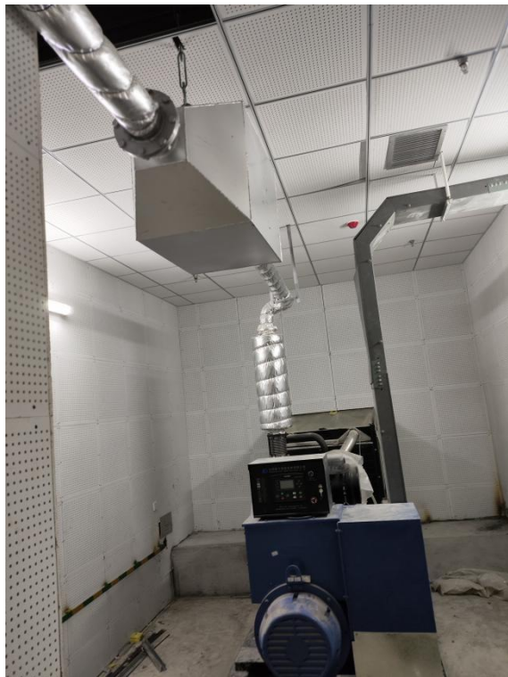
柴油发电机自带硝烟净化装置+楼顶排气筒（发电机燃烧废气）
