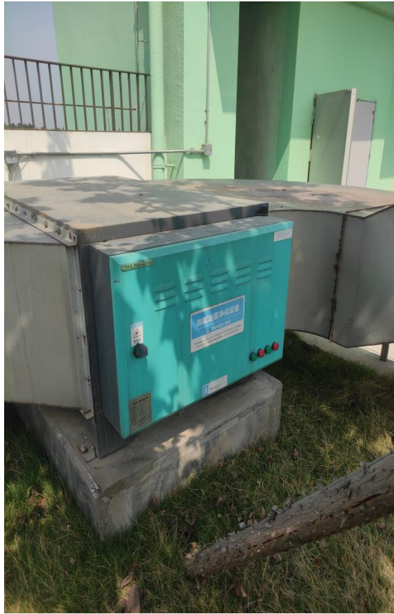
油烟净化器+楼顶排气筒（食堂油烟）
