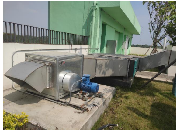
UV 光氧催化设备+15m 排气筒（污水处理站恶臭）
