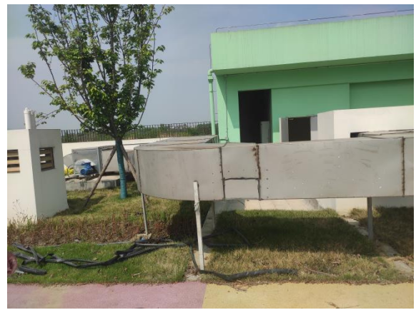
油烟净化器+楼顶排气筒（食堂油烟）
