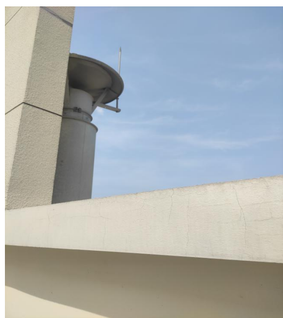
柴油发电机自带硝烟净化装置+楼顶排气筒（发电机燃烧废气）
