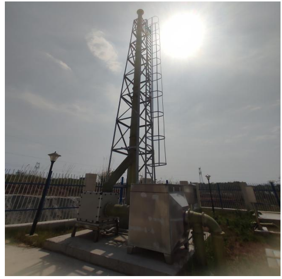
UV 光氧催化设备+15m 排气筒（污水处理站恶臭）
