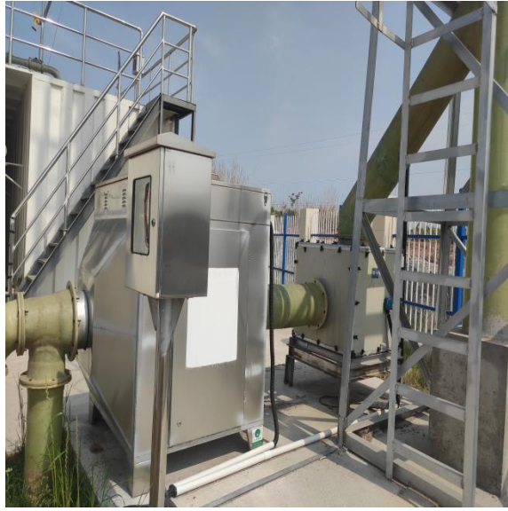
UV 光氧催化设备+15m 排气筒（污水处理站恶臭）
