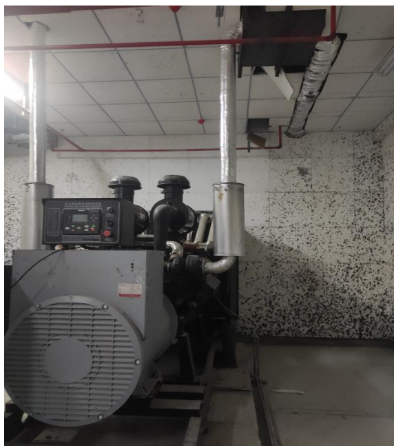
柴油发电机自带硝烟净化装置+楼顶排气筒（发电机燃烧废气）
