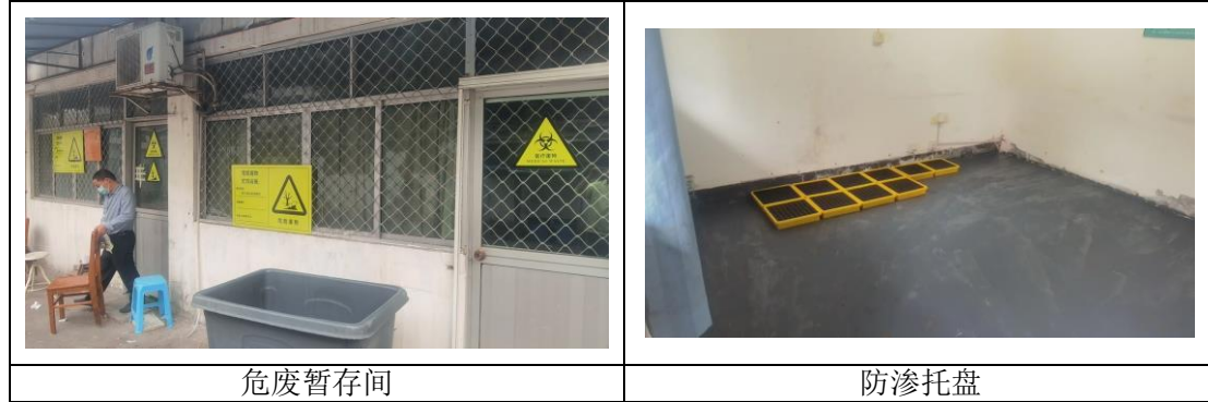
图 3-7 危废暂存间环保设施图
