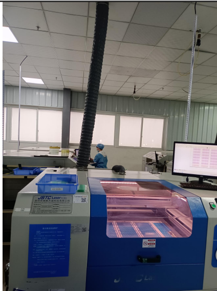
密闭设备+抽风管道
