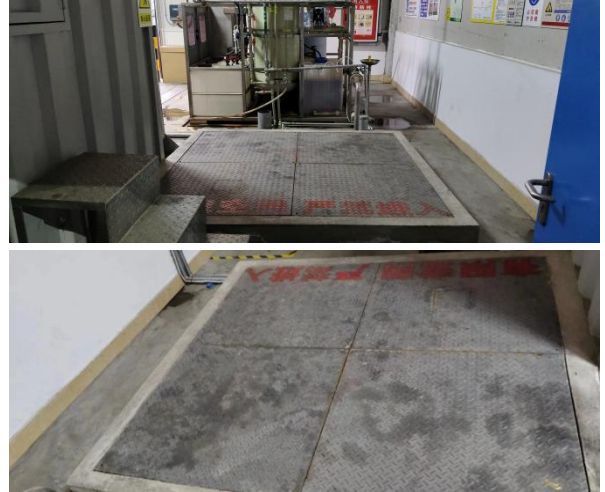
污水处理站事故应急池（油墨存放间依托）
