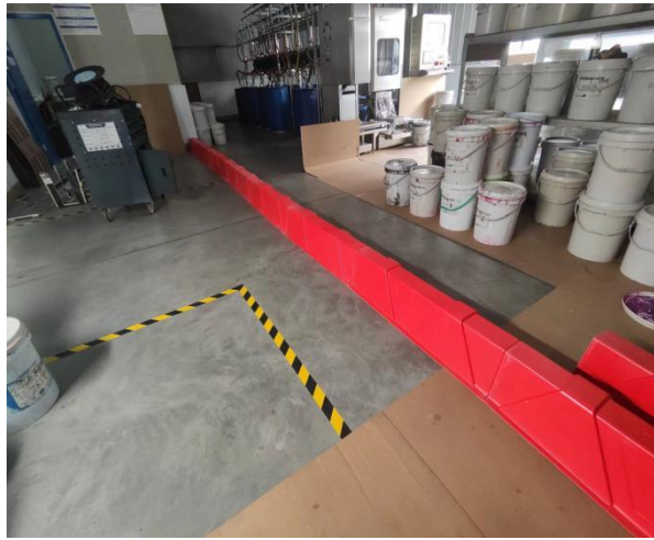
围堰及导流沟（油墨存放间）
