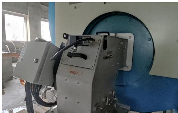
低氮燃烧装置+锅炉排气筒
