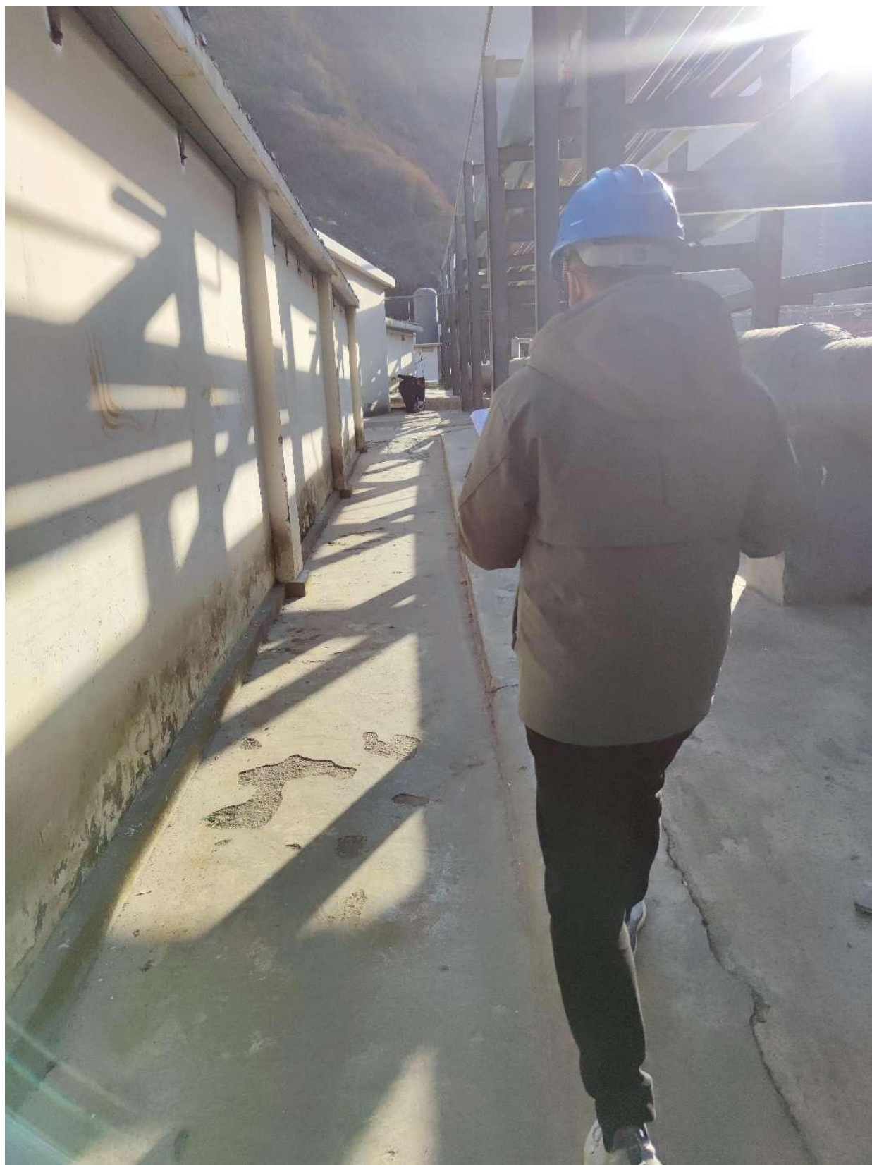
现场调查照片
