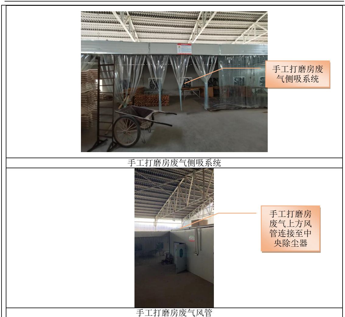
图 3-2 粉尘废气治理设施图
