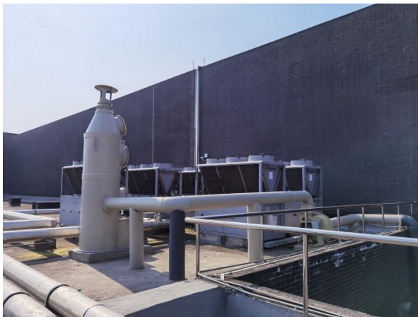
无机废气：酸雾喷淋塔（TA003）+15m 排气筒（DA003）
