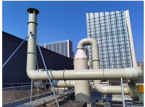
有机废气：二级活性炭吸附箱（TA002）+15m 排气筒（DA002）
