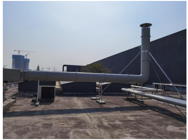
有机废气：二级活性炭吸附箱（TA001）+15m 排气筒（DA001）
