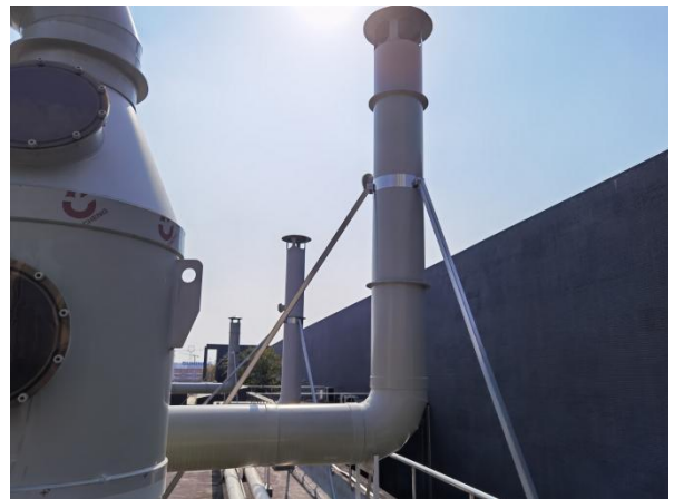
无机废气：酸雾喷淋塔（TA003）+15m 排气筒（DA003）
