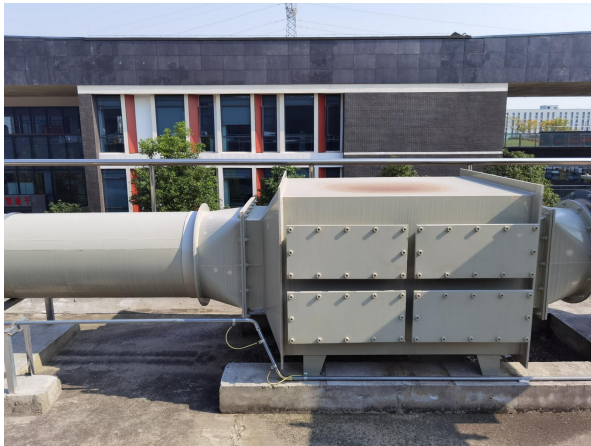
有机废气：二级活性炭吸附箱（TA002）+15m 排气筒（DA002）
