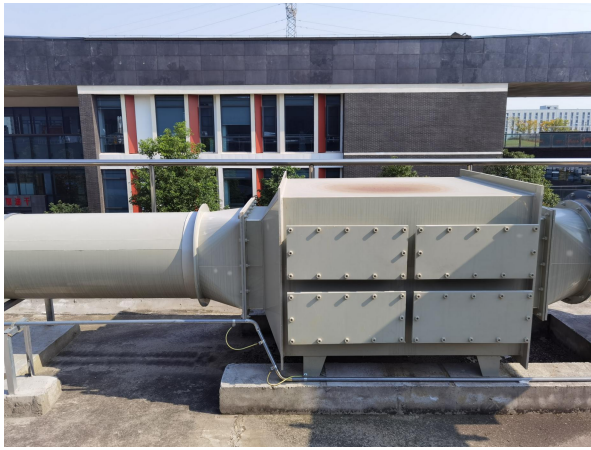
有机废气：二级活性炭吸附箱（TA001）+15m 排气筒（DA001）
