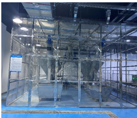
密闭措施及集气管道
