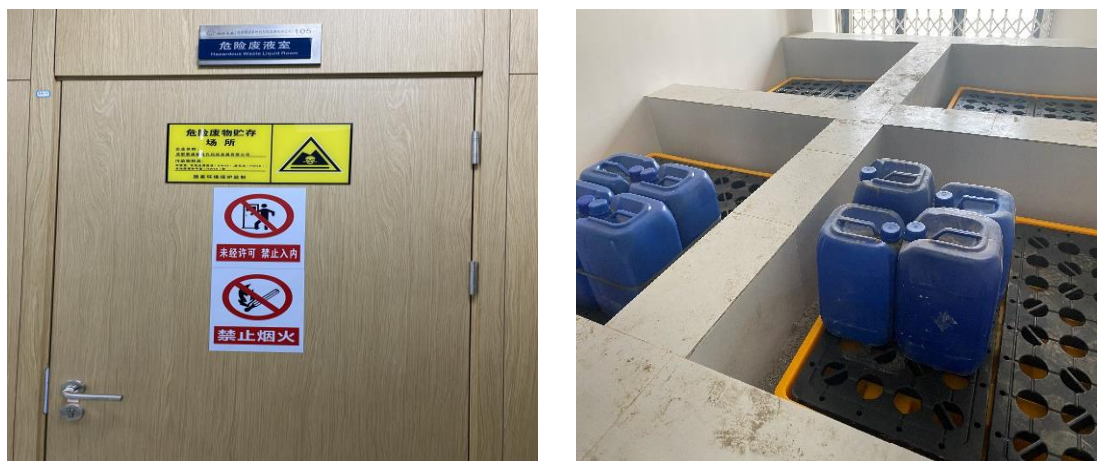
图 4-5 危险废物处理设施
