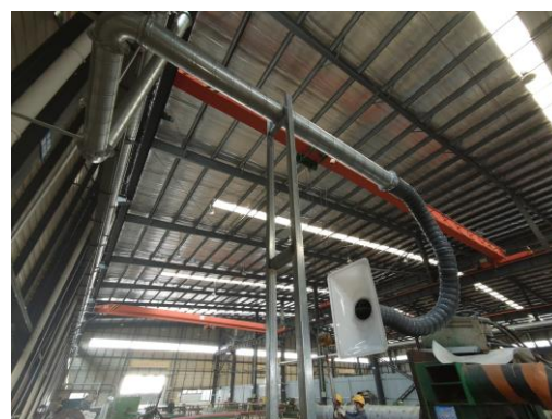
钢塑复合管生产线上方集气罩
