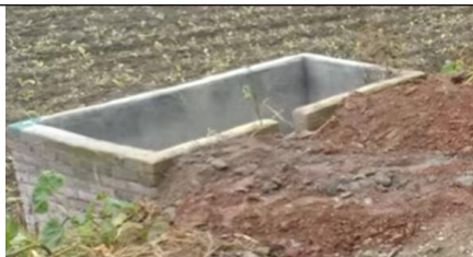
车辆清洗废水沉淀池
