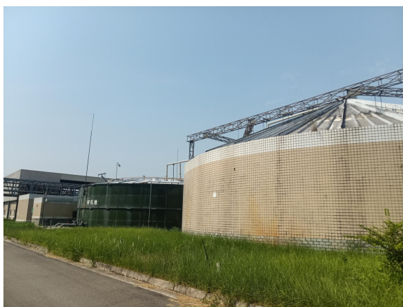
废水处理站（依托新迪生物）
