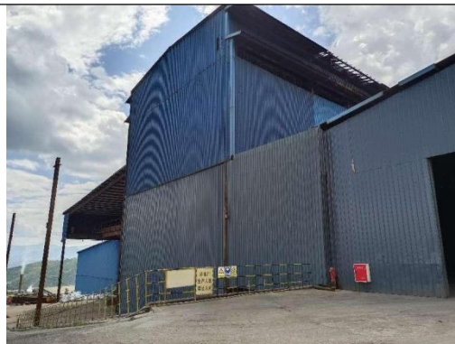
生产车间厂房
