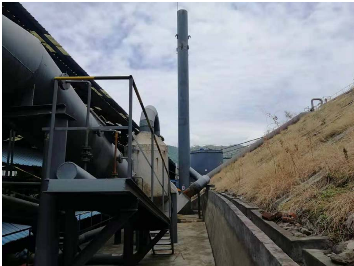
药剂车间排气筒
