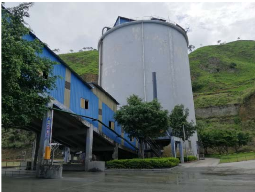
原矿仓及其喷淋除尘器
