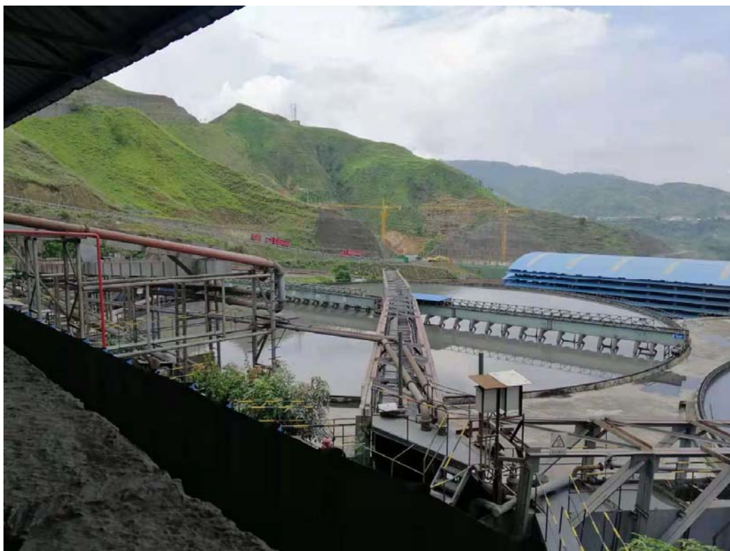
厂区尾矿浓缩池
