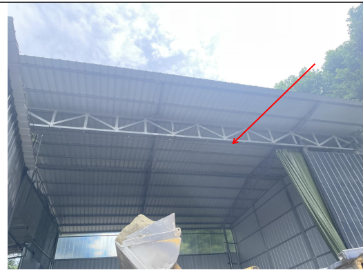
喷雾除尘装置
