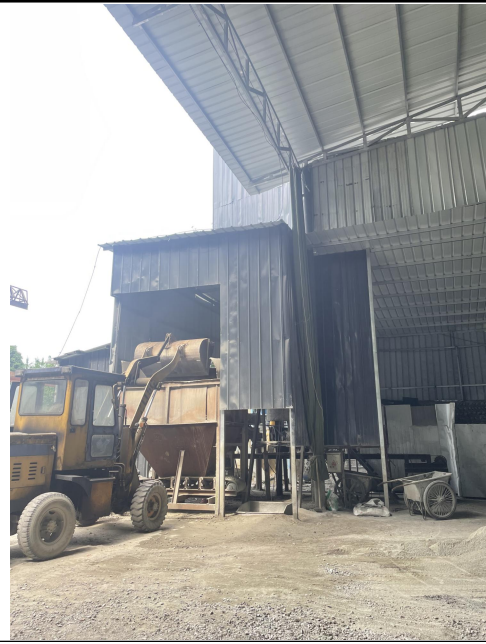
投料、搅拌区域封闭
