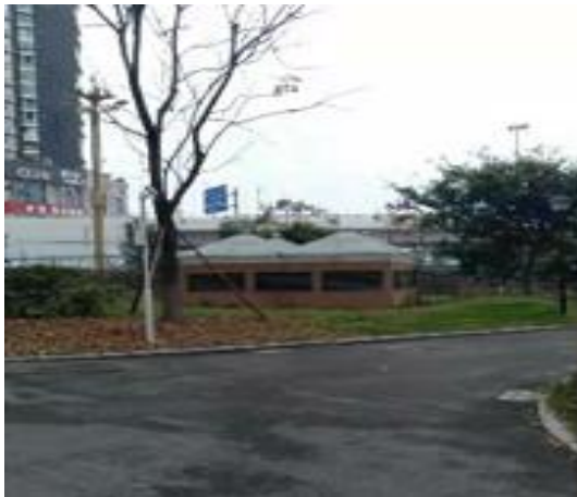
地下车库排风口
