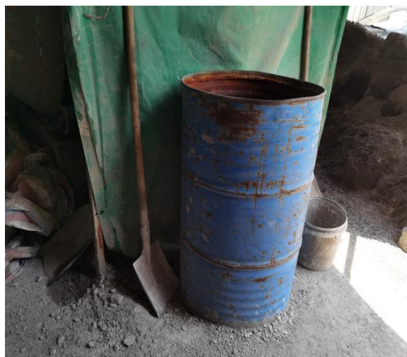
空桶（收集搅拌机清洗废水）
