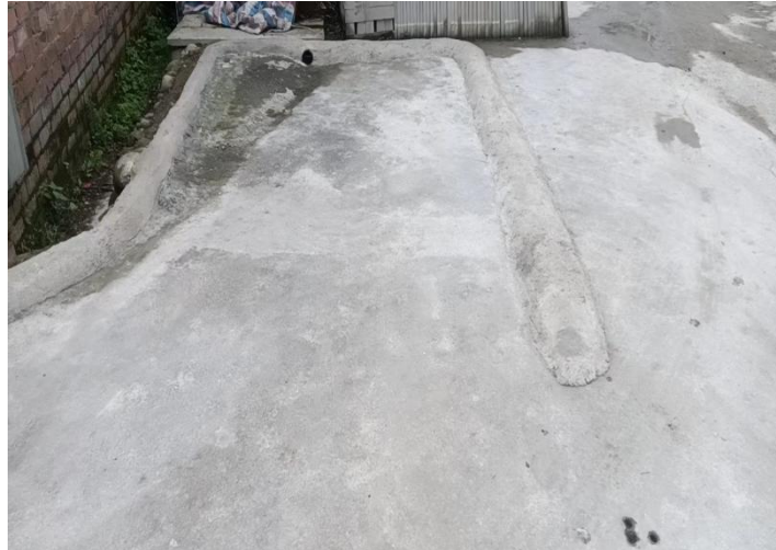
车辆冲洗废水截流围挡
