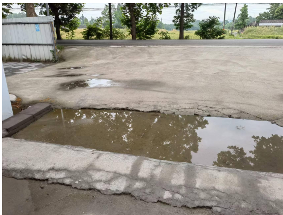
凹槽和截排水沟
