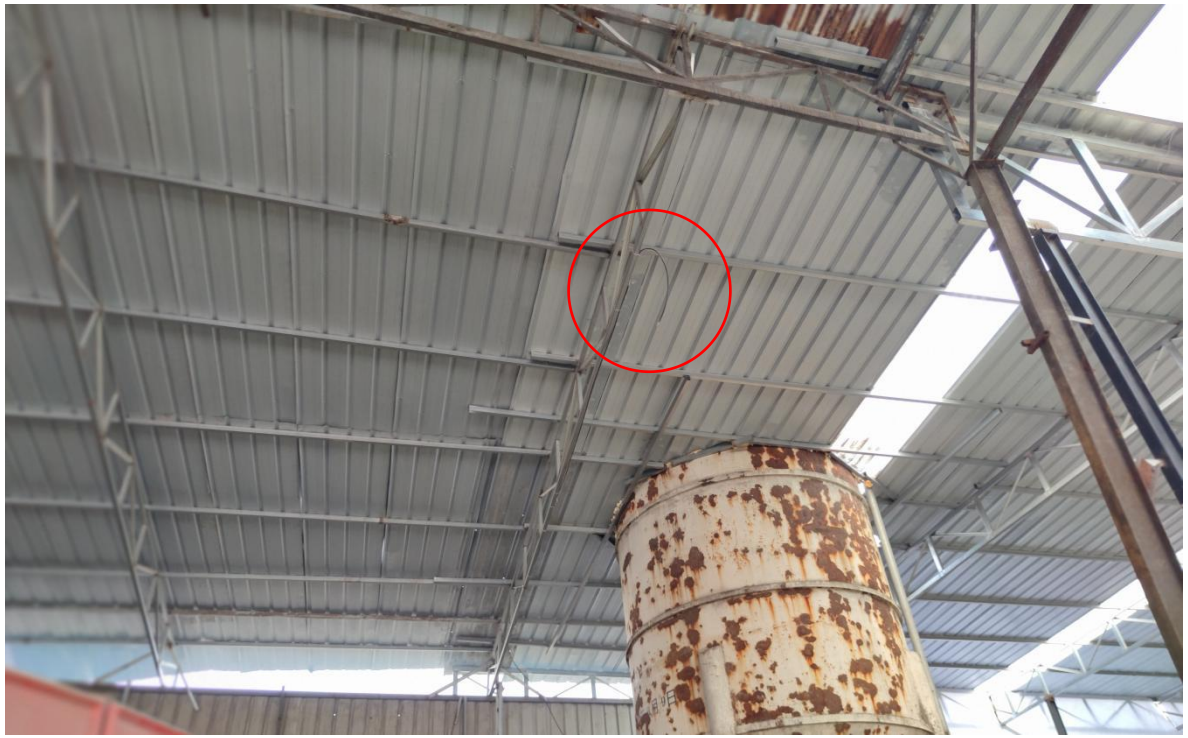
喷淋降尘装置
