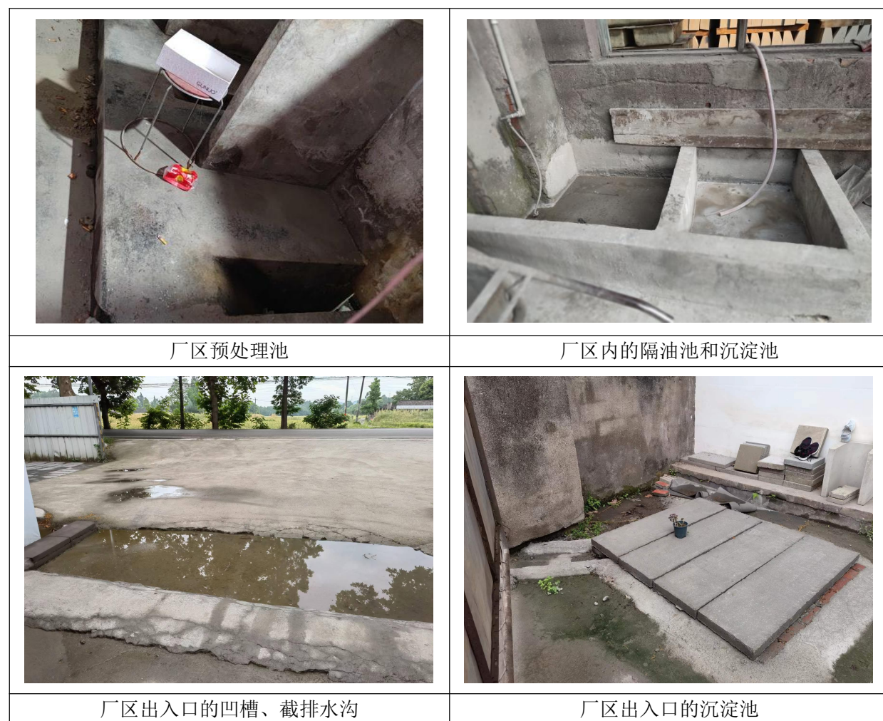
图 3-2 本项目废水治理措施现场照片
