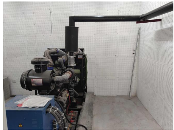
柴油发电机消声处理和加装防震垫圈
