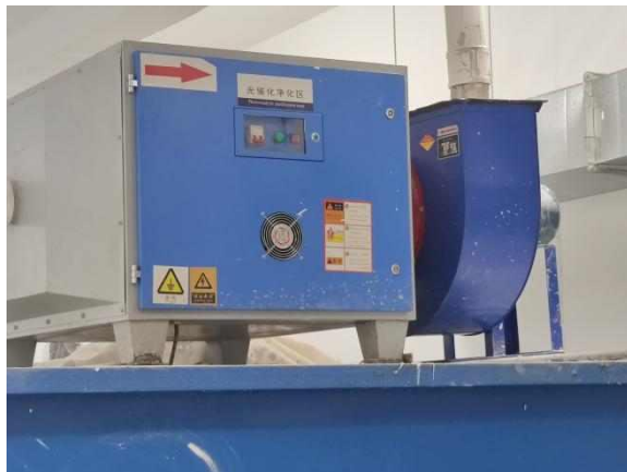
一体化污水处理站恶臭处理装置
