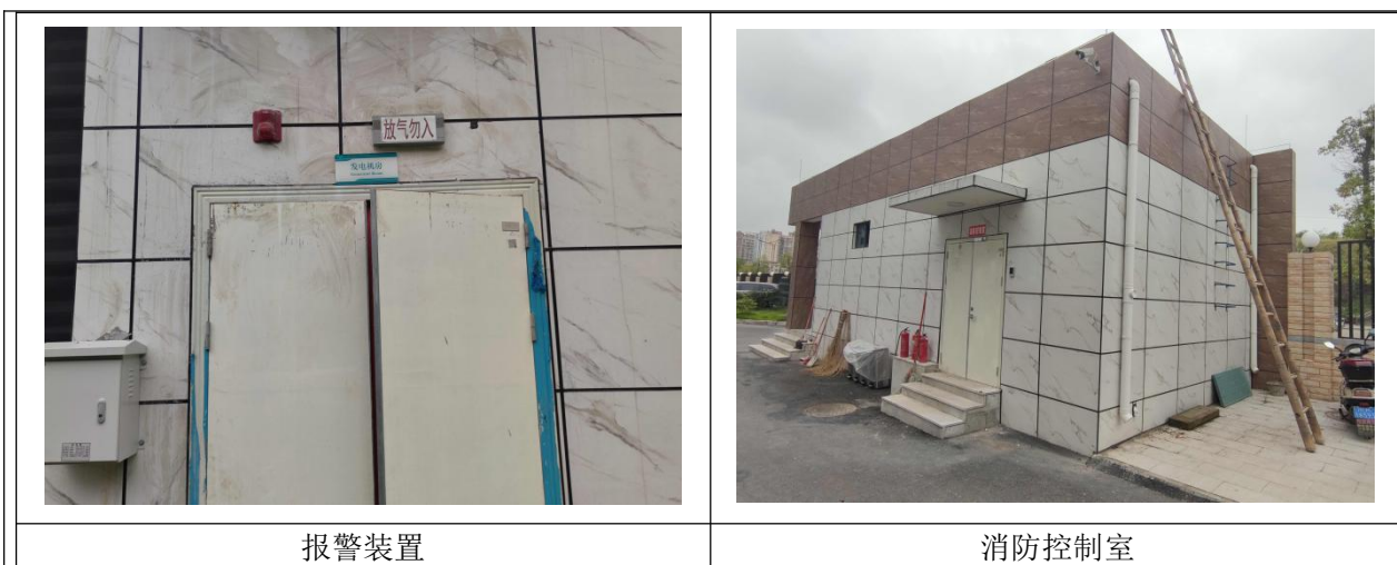
图 3-7 本项目风险防范的现场照片
