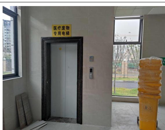
医疗废物专用电梯
