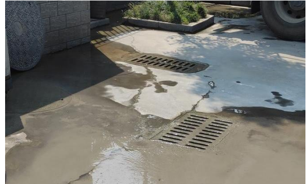
二级沉淀池+清水池
