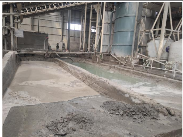
二级沉淀池+砂石分离机+废水废浆收集利用池+储水罐
