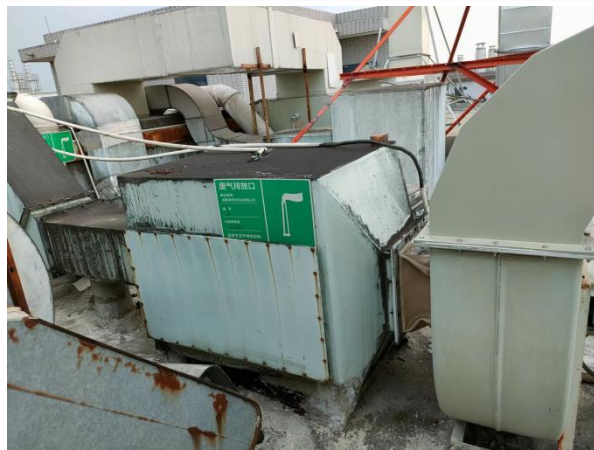
滴定室、气相色谱室、液相色谱-质谱室、液相色谱-质谱-质谱室、高效液相色谱室、准备室、试剂库房、危废暂存间（两级活性炭吸附装置+排气筒）
