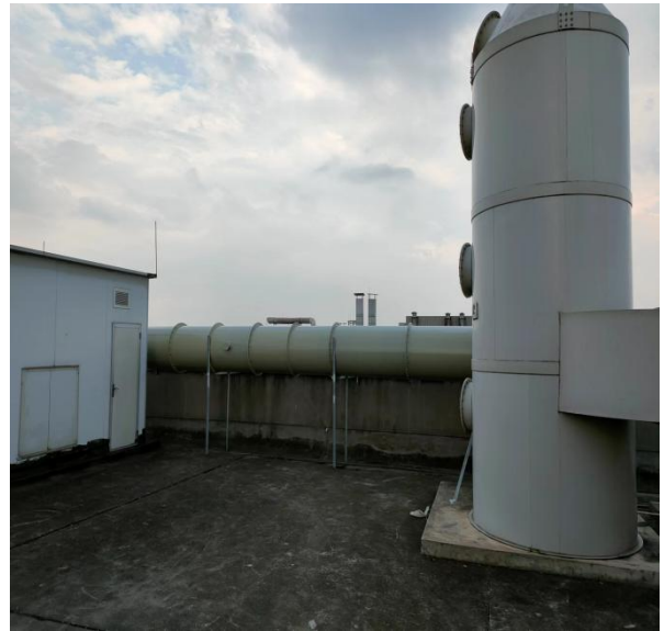
药化实验室①、药化实验室②（两级活性炭吸附装置+碱液喷淋塔+排气筒）
