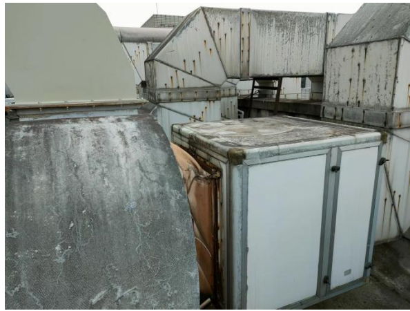
药化实验室⑤（两级活性炭吸附装置+排气筒）
