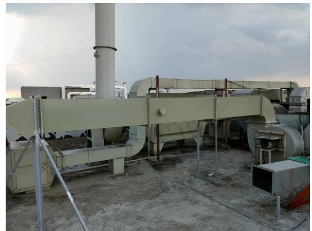
滴定室、气相色谱室、液相色谱-质谱室、液相色谱-质谱-质谱室、高效液相色谱室、准备室、试剂库房、危废暂存间（两级活性炭吸附装置+排气筒）
