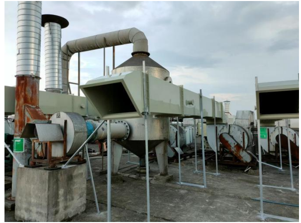
药化实验室③（两级活性炭吸附装置+排气筒）
