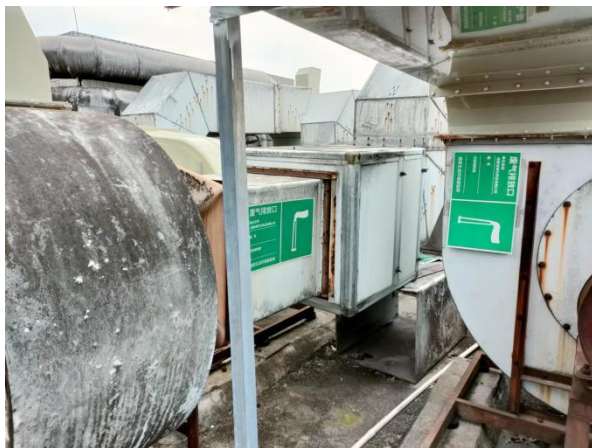
药化实验室④（两级活性炭吸附装置+排气筒）
