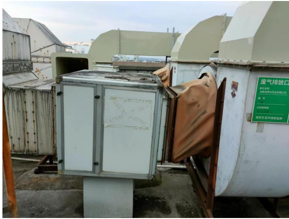
药化实验室③（两级活性炭吸附装置+排气筒）
