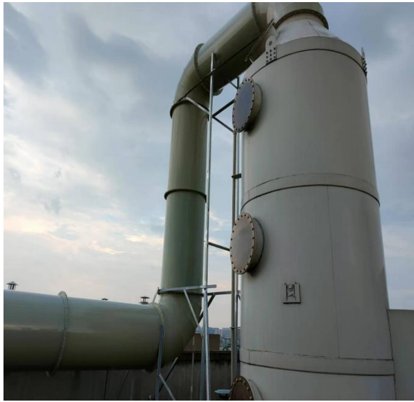
药化实验室①、药化实验室②（两级活性炭吸附装置+碱液喷淋塔+排气筒）
