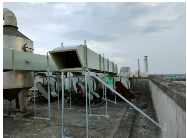
药化实验室④（两级活性炭吸附装置+排气筒）
