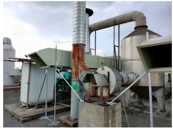
药化实验室⑤（两级活性炭吸附装置+排气筒）
