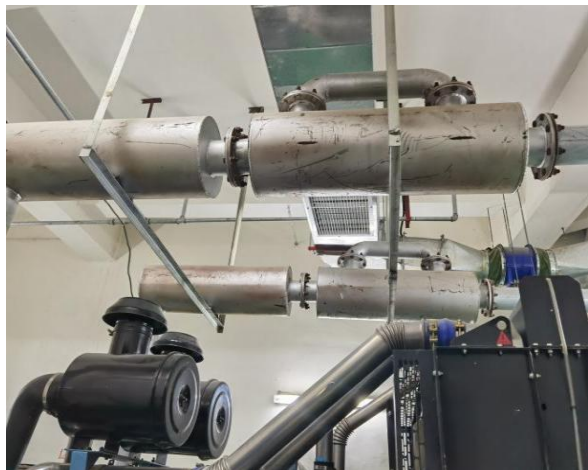
柴油发电机及自带尾气净化装置
