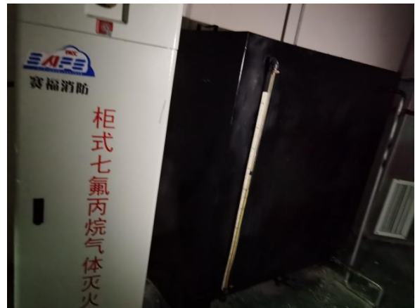
柴油发电机房地面情况及七氟丙烷气体灭火器
