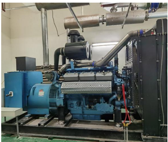
柴油发电机及自带尾气净化装置
