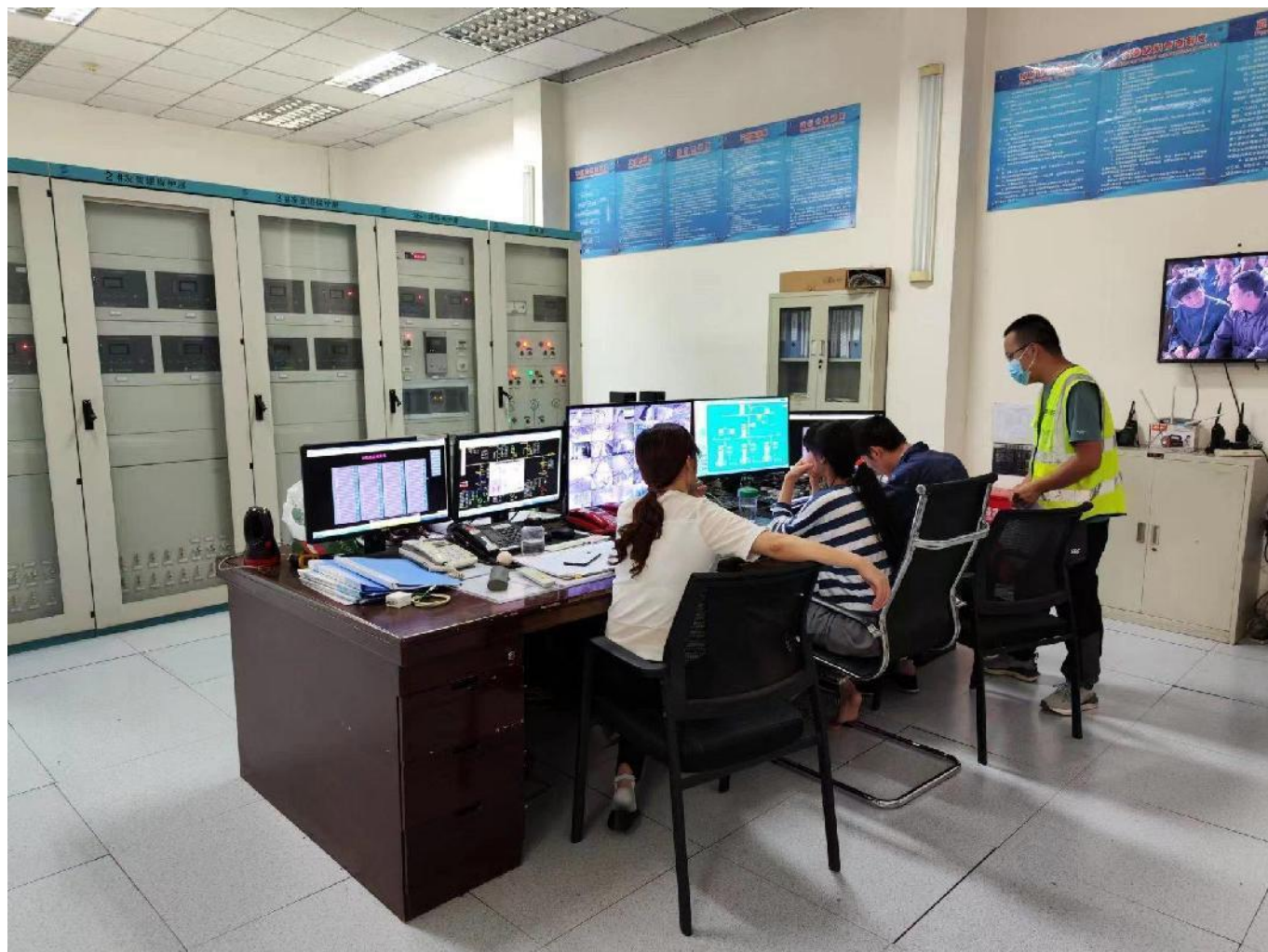
现场调查照片
