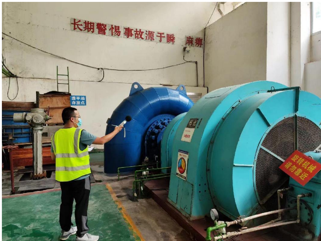
现场采样、检测照片
