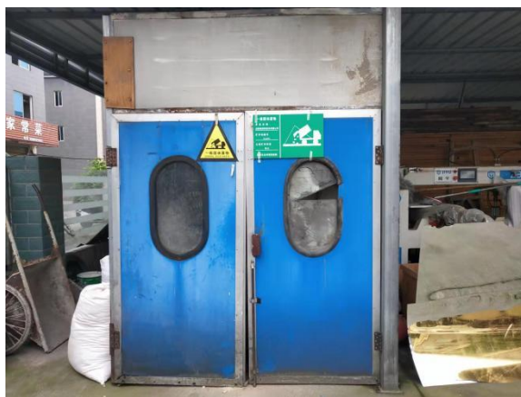
一般固体废物暂存间
