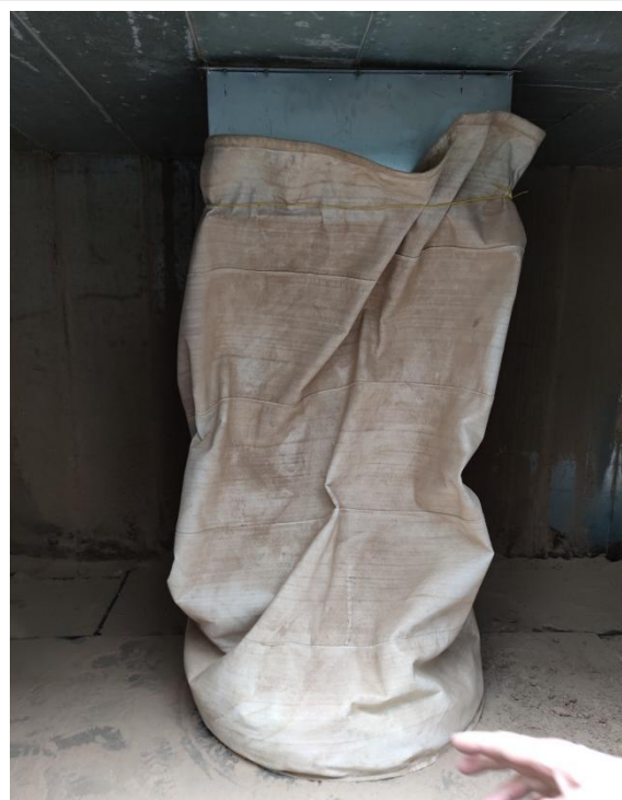
中央除尘器收集的粉尘
