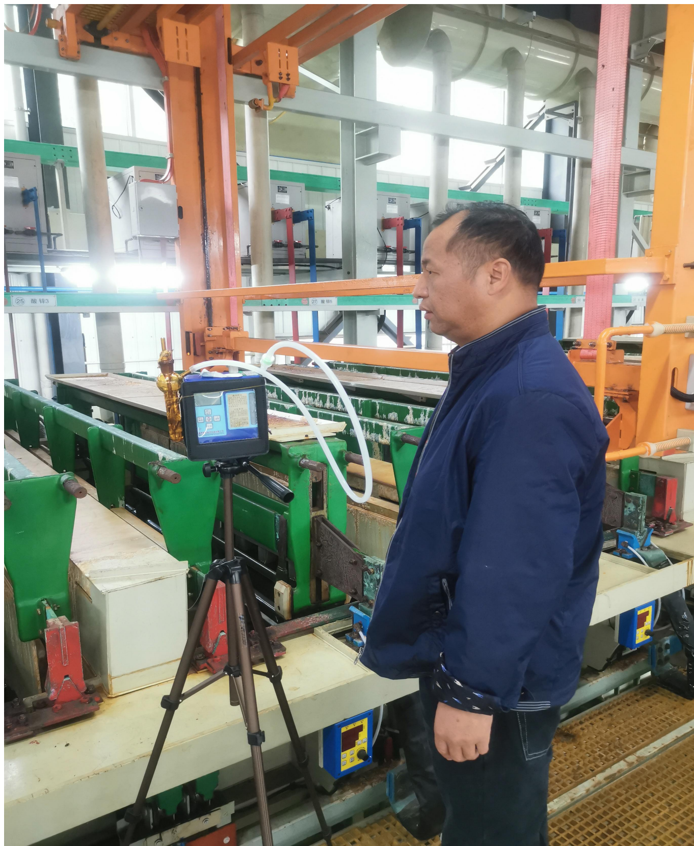
现场采样、检测照片
