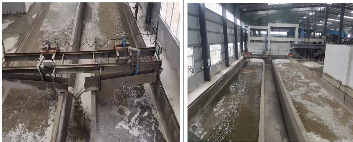
生产废水处理系统
