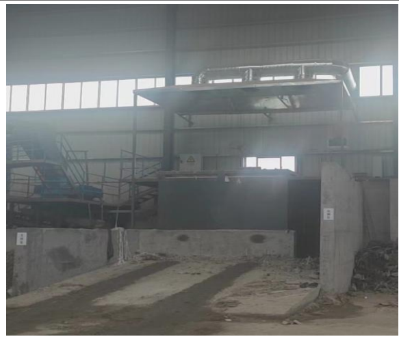
装载机上料投料口集气罩
