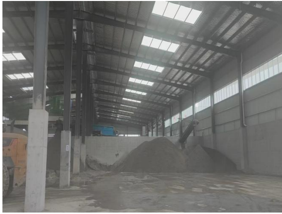
成品砂堆放区
