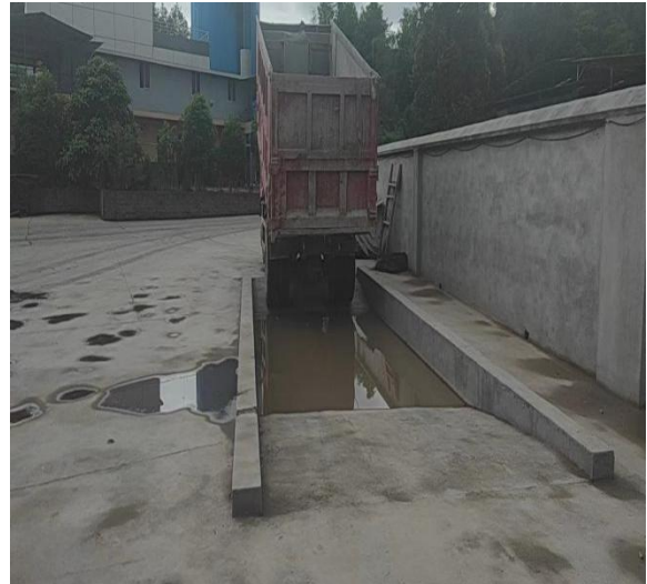
厂区进出口车辆冲洗凹槽
