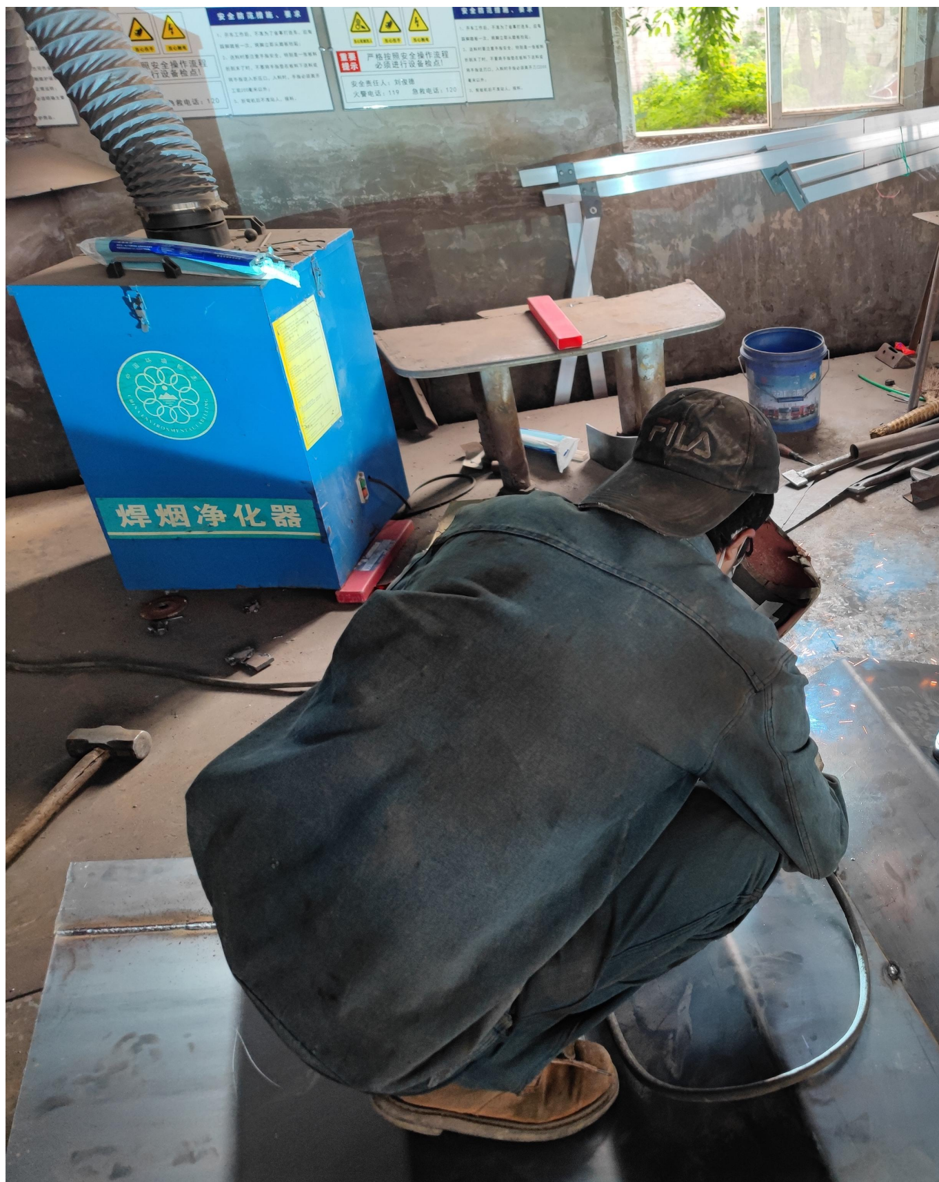
现场调查照片
