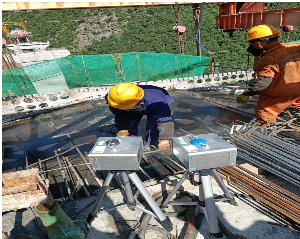
现场采样、检测照片
