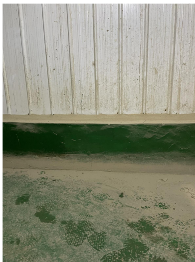
地面防渗+围堰
