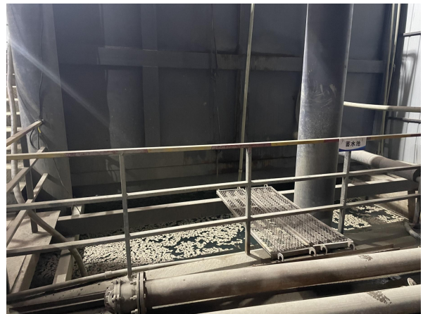
蓄水池防渗混凝土池体
