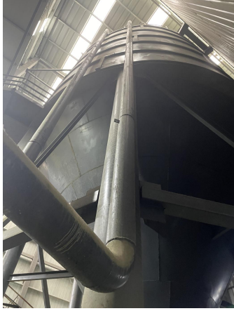
污水罐钢结构池体
