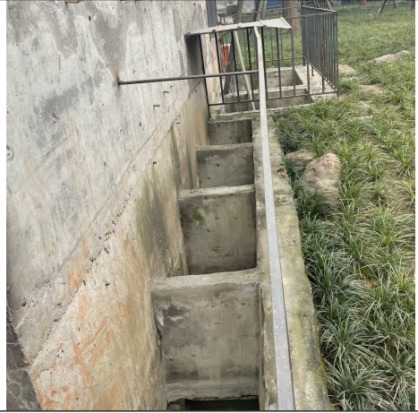
雨水收集沟防渗混凝土池体
