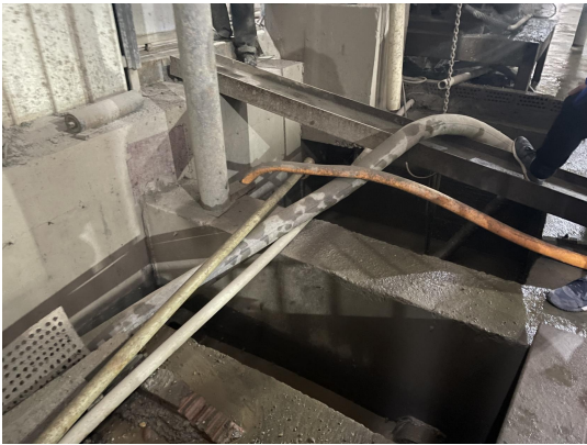
一级沉淀池防渗混凝土池体
