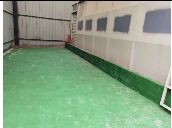
柴油存放区地面防渗
