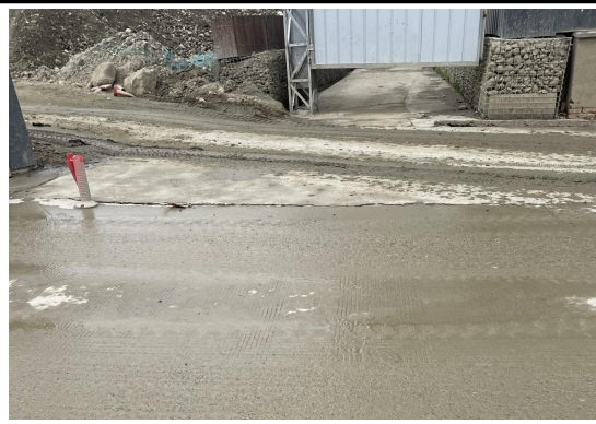
原料堆场汽车运输路面硬化
