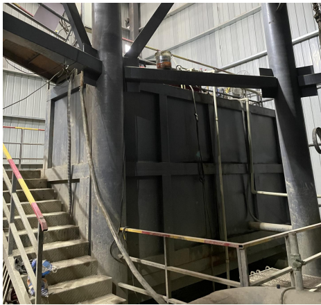
加药罐钢结构池体
