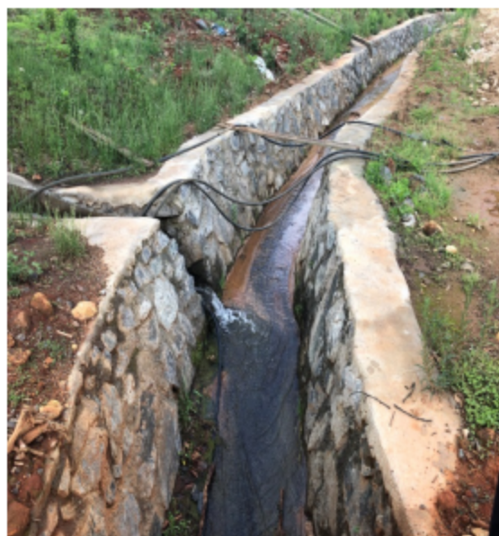
尾矿库坝肩截洪沟
