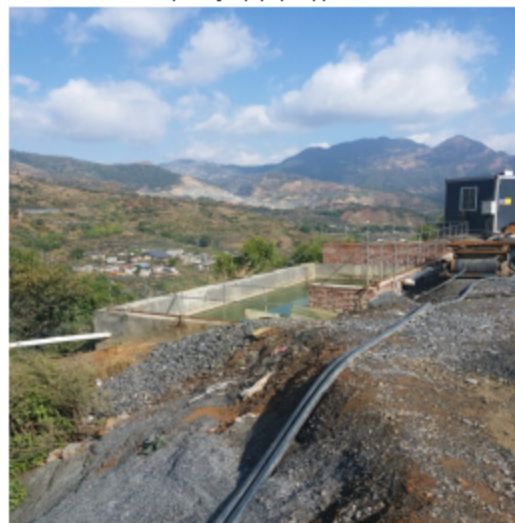
选厂废石加工生产线沉淀池
