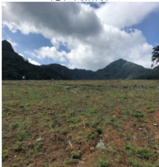
尾矿库堆积坝
