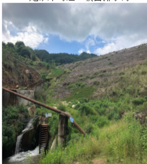
尾矿库初期坝
