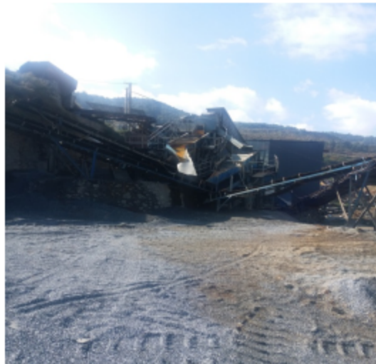
选厂道碎石堆场
