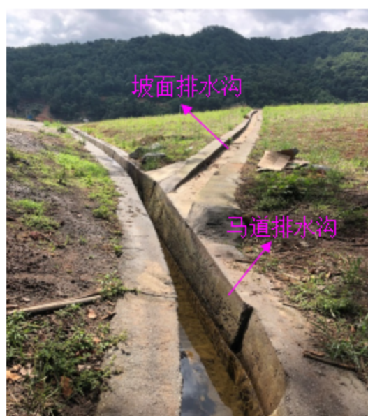
尾矿库马道、坡面排水沟
