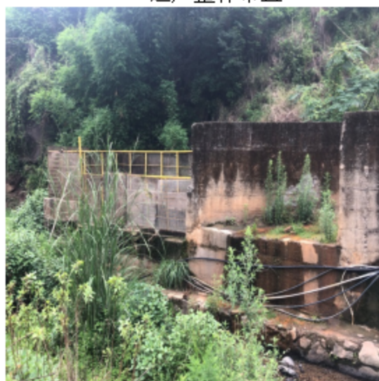
尾矿库排洪隧洞
