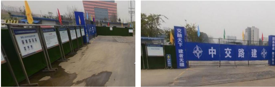
施工期围挡施工照片
