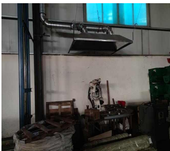
焊接机器人上面的集气罩
