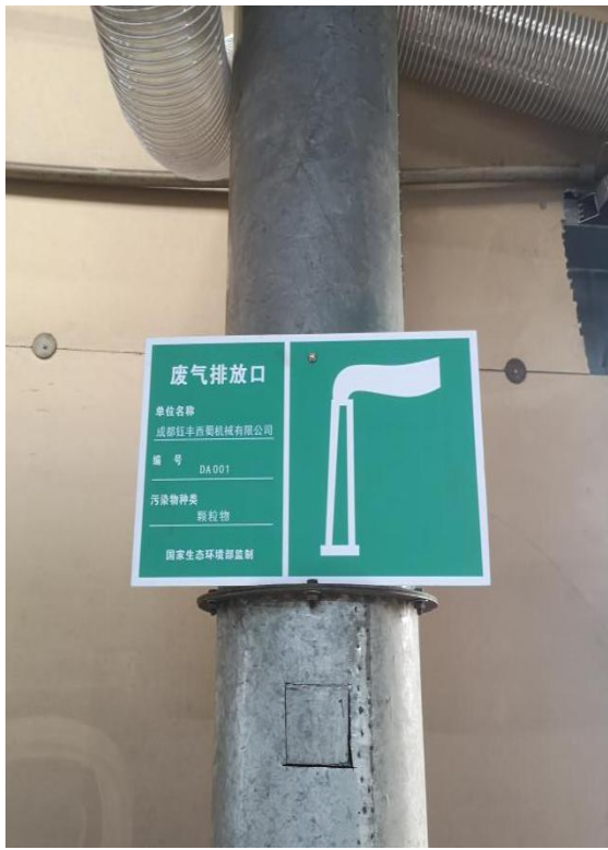
DA001 排气筒环保标识牌
