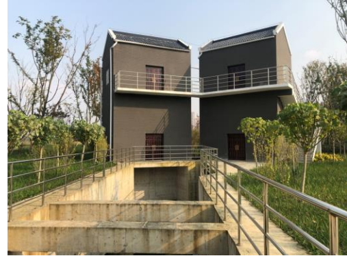
进水渠、调水闸和泄水闸
