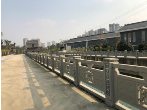
东干渠和节制闸
