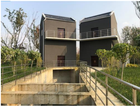
项目进水渠、泄水闸、调水闸
