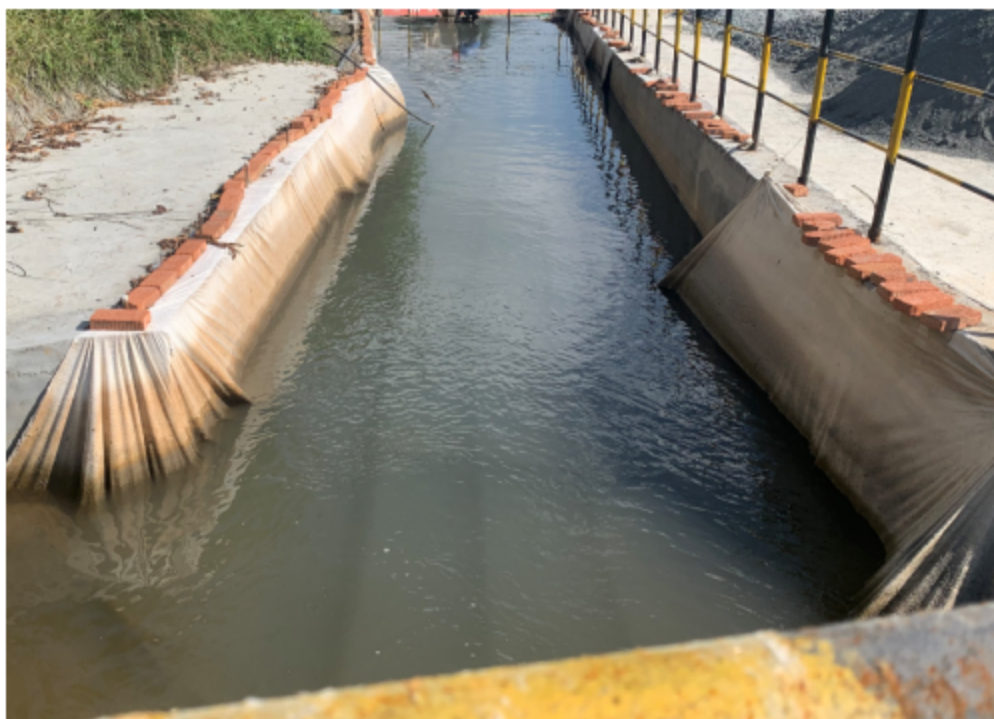
图 6-3 渗滤液收集池
