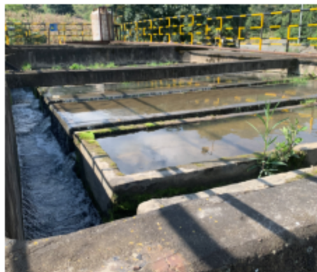
尾矿库渗滤液泵站和渗滤液中转池
