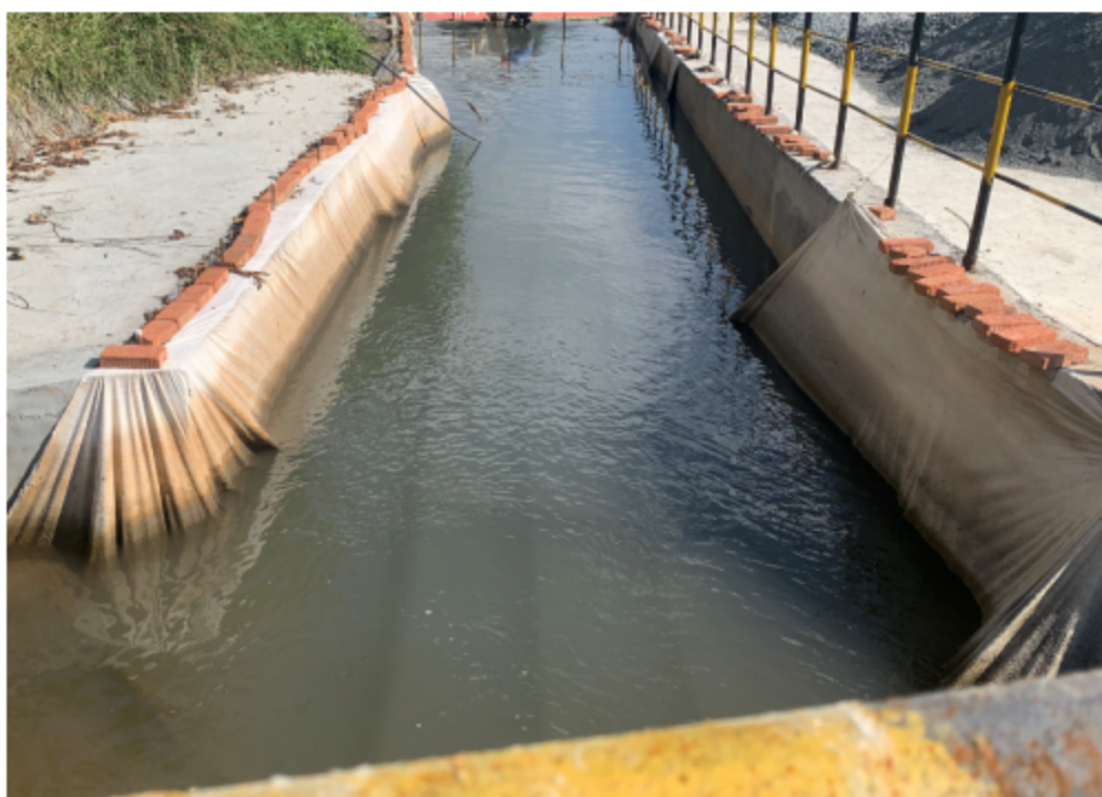
渗滤液收集池
