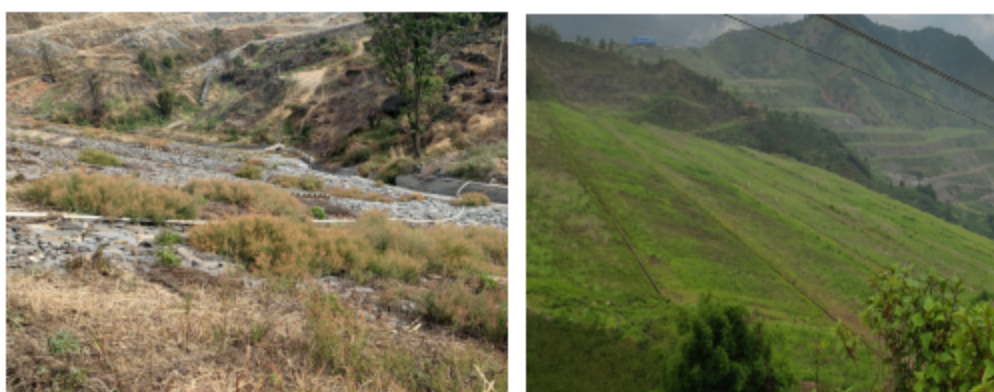
尾矿库初期坝尾矿库堆积坝及绿化
