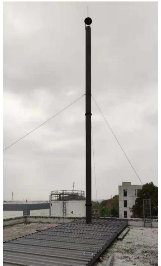
楼顶的锅炉废气排气筒
