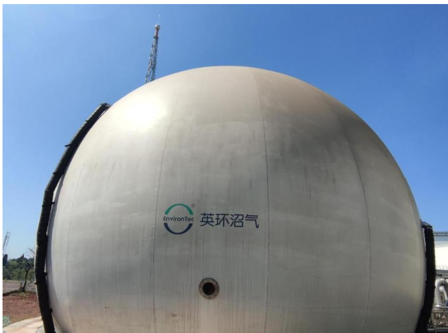
图 3.7-8 沼气囊实际现场照片
