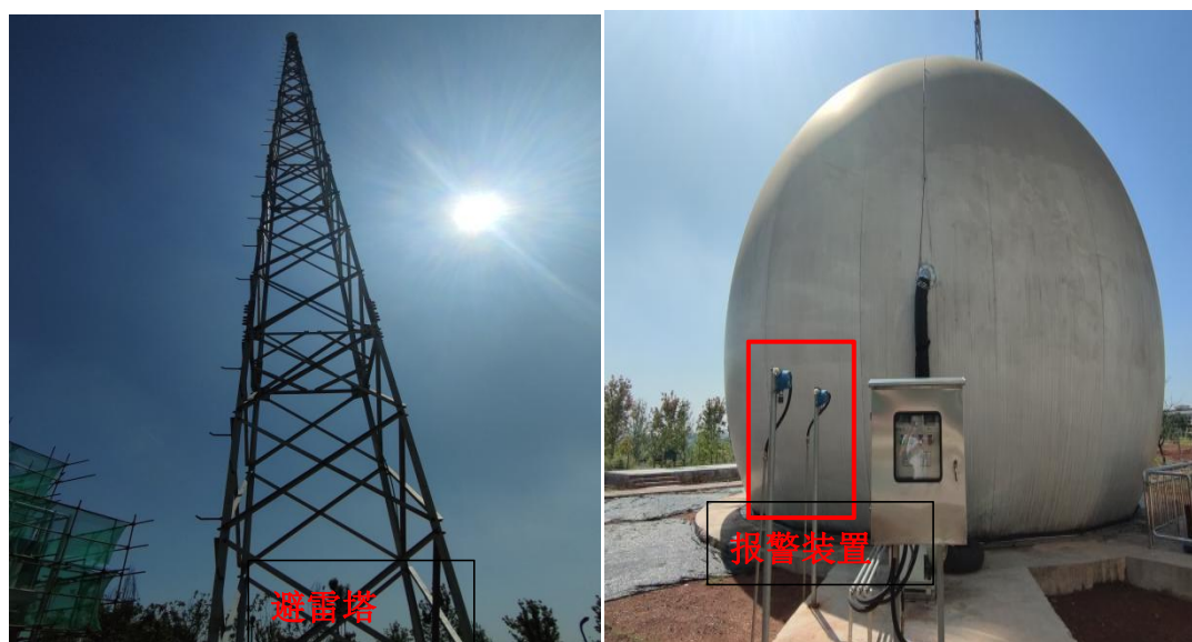
图 4.2-1 沼气囊报警装置以及旁边的避雷塔
