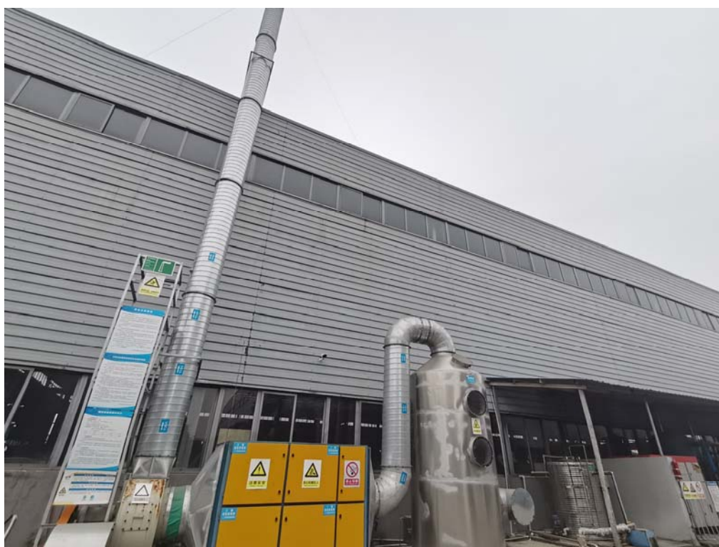
图 3-2 氯化氢废气治理工艺图
