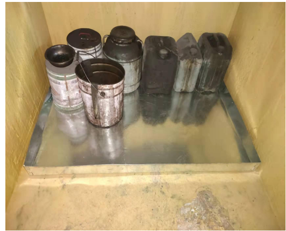
危废暂存间托盘
