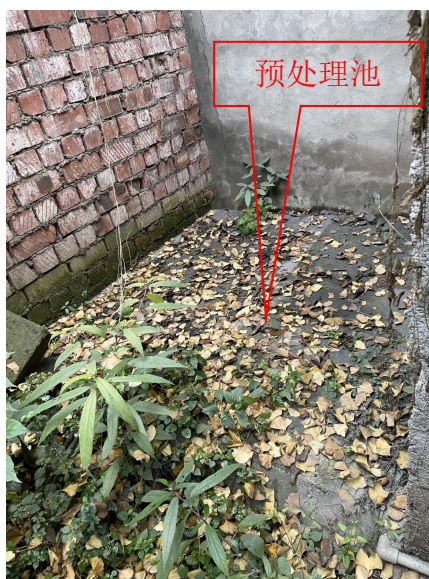
图 3.2 本项目废水治理措施现场照片
